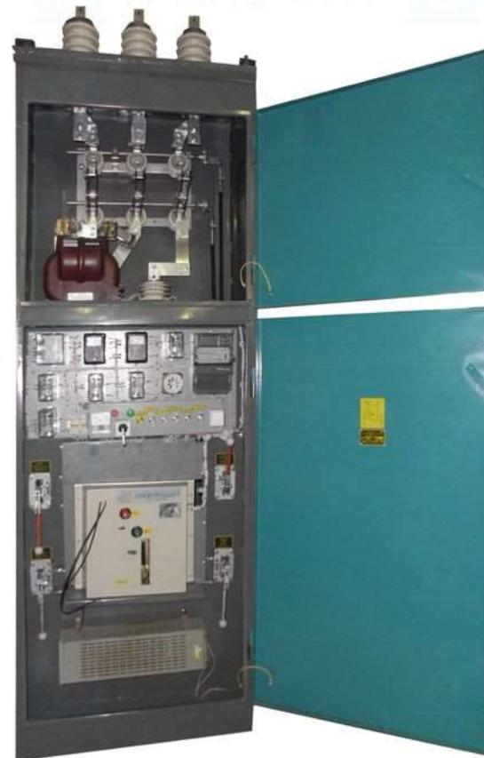
Подстанция обеспечивает учет активной энергии с помощью счетчика и соответствующих трансформаторов тока, имеет электрические и механические блокировки, обеспечивающие безопасную работу обслуживающего персонала. Для создания нормальных условий работы электроаппаратуры в КТП-03 имеет обогрев.
